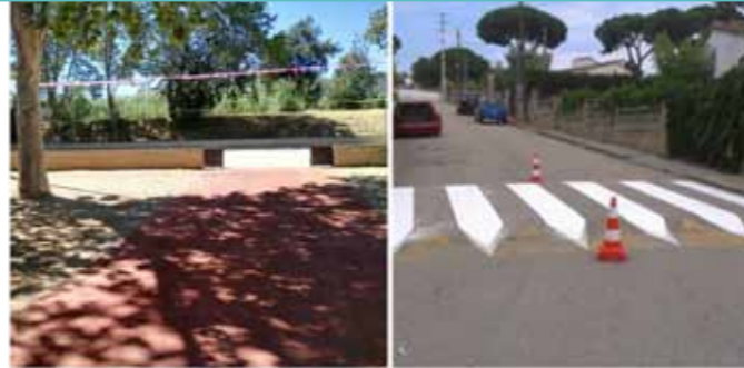
Al veïnat de Fibracolor s'han creat dues noves rampes d'accés que permeten millorar l'accessibilitat
